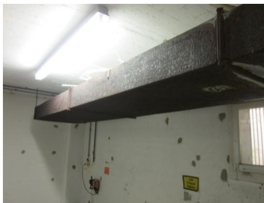
*Conduite de ventilation en mauvais état*
