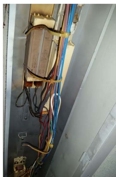
Etat des luminaires des salles
