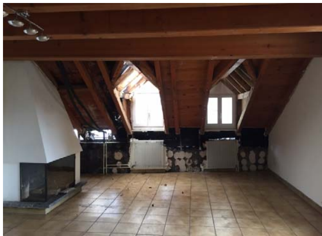
Lucarne, isolation des murs détruits
