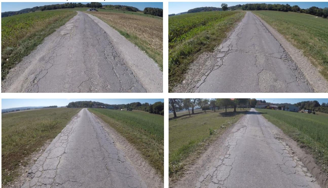
Figure 1 : Dégâts superstructure
