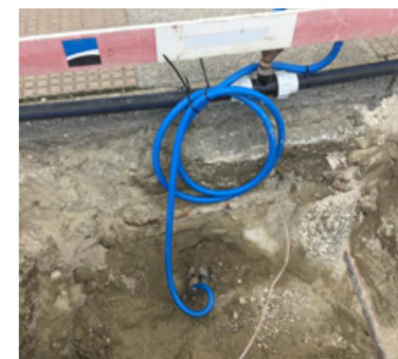
Raccordement provisoire pour un privé durant un chantier
