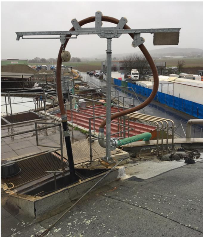
Aspiration de la filasse dans les digesteurs
