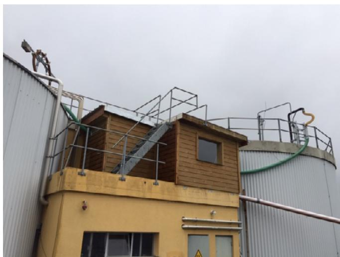
Fabrication d'un couvert pour la pompe à filasse de la STEP
