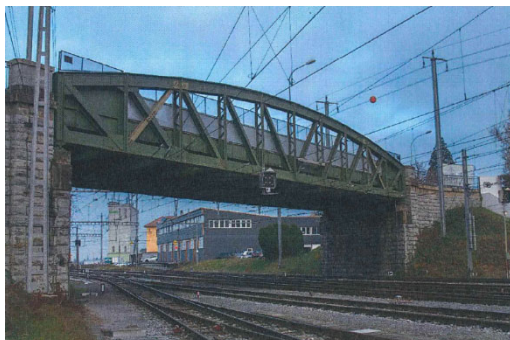
Figure 2 : Pont vu de profil côté Corcelles-près-Payerne
