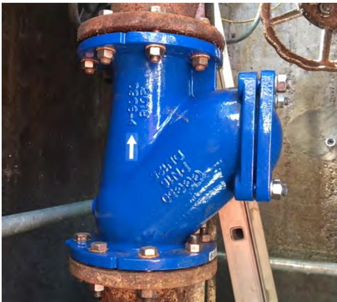
Remplacement d'un clapet à boule à la STAP de Bas de Vuary
