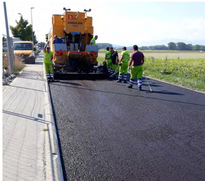
Pose d'un enrobé coulé à froid à la route de la Charrière d'Estavayer
