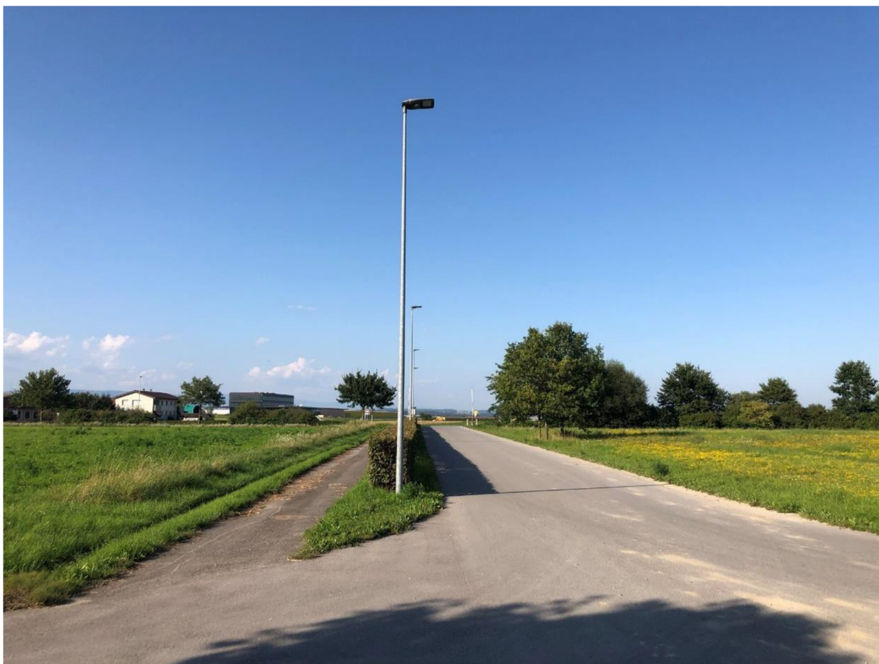
Route de desserte principale et éclairage public
