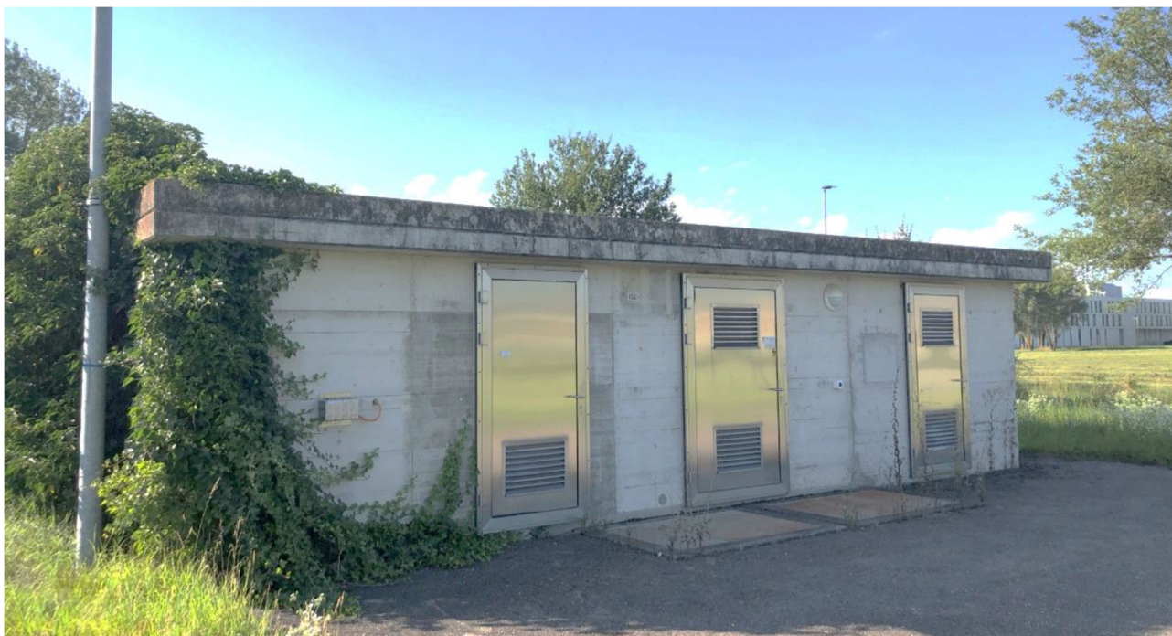
Bâtiment technique regroupant les sous-stations de Groupe E et de Groupe E Celsius ainsi que la station d'aspiration des eaux usées et la STAP de refoulement en direction de la STEP
