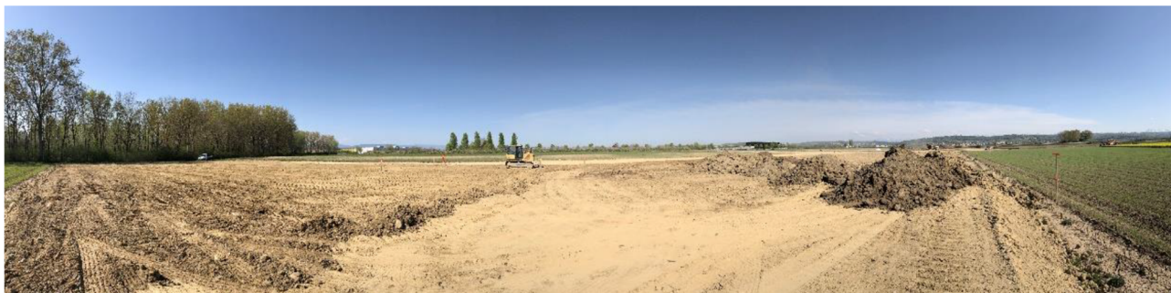
Remblayage général des parcelles pour reprofilage de la topographie
