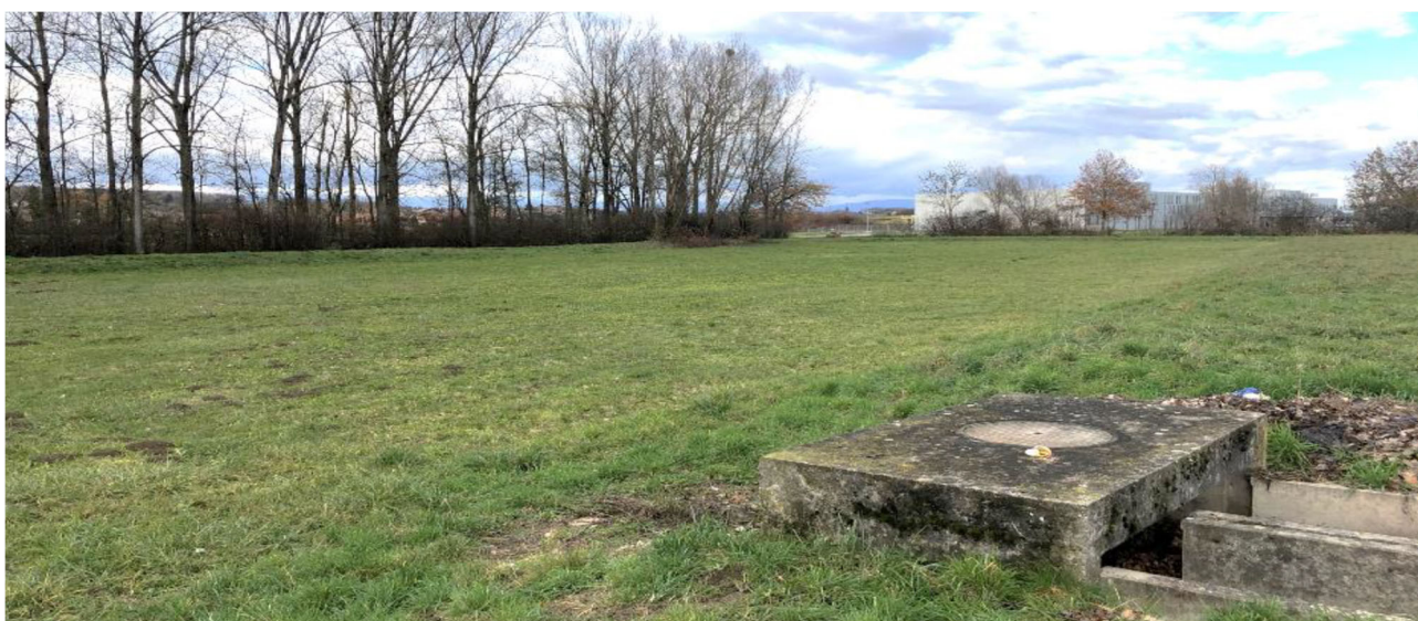
Bassin de rétention à ciel ouvert des eaux de surface
