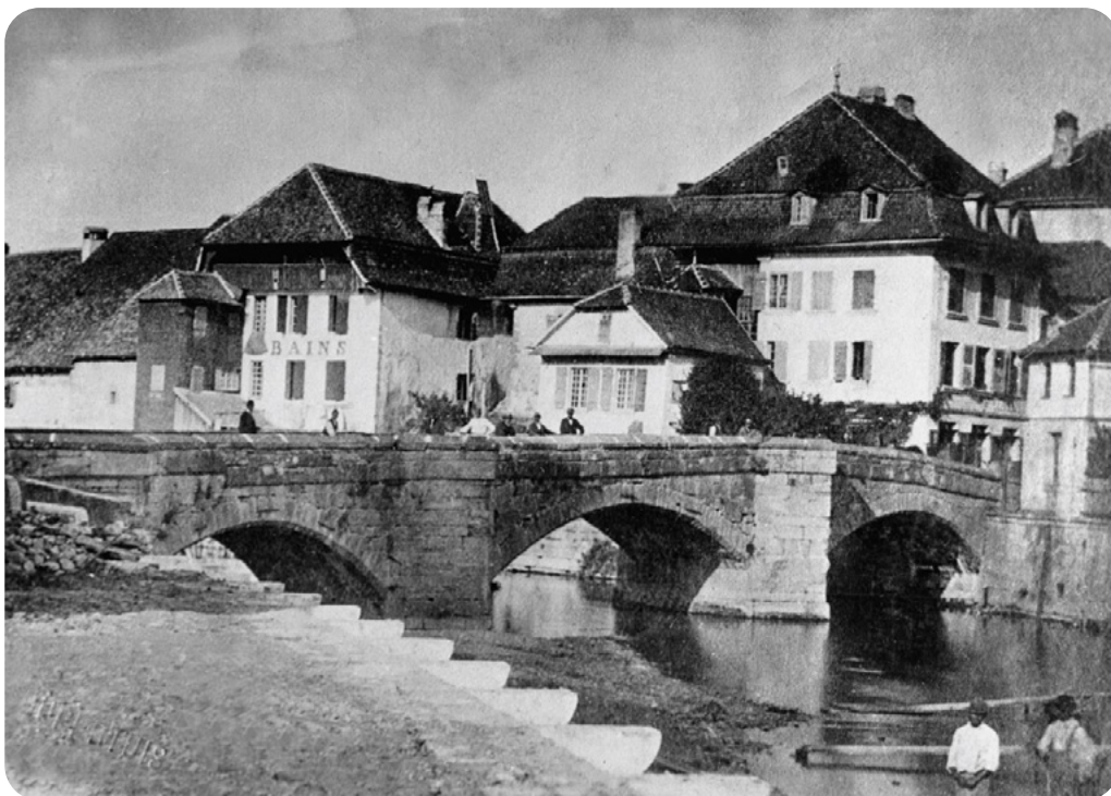
Une image du Vieux Payerne, le pont de ville en pierre démolé en 1868.
