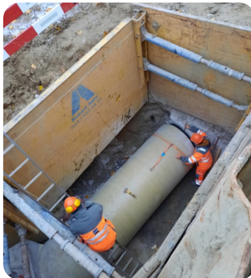
Travaux d'assainissement mise en séparatif
