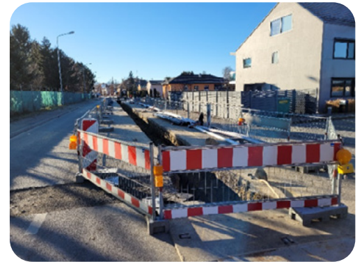
Travaux du remplacement de la conduite d'eau
