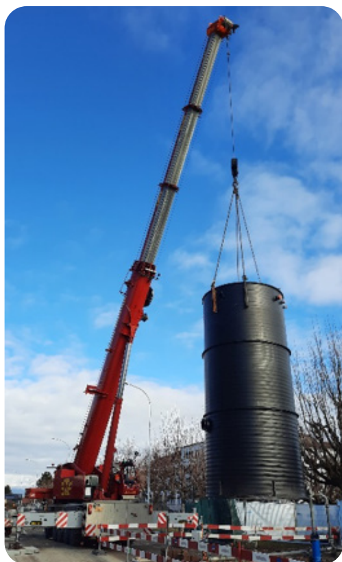
Mise en place de la station de pompage
