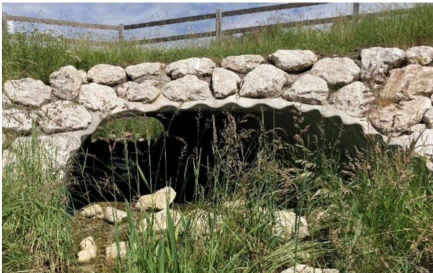
Figure 8 : Exemple de réalisation d'une demi-buse pour garantir le passage agricole
