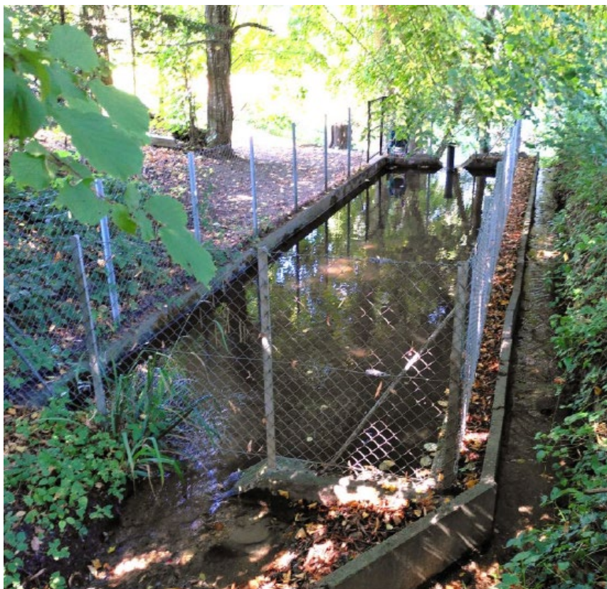
Figure 2 : Bassin incendie à Vers-chez-Savary
