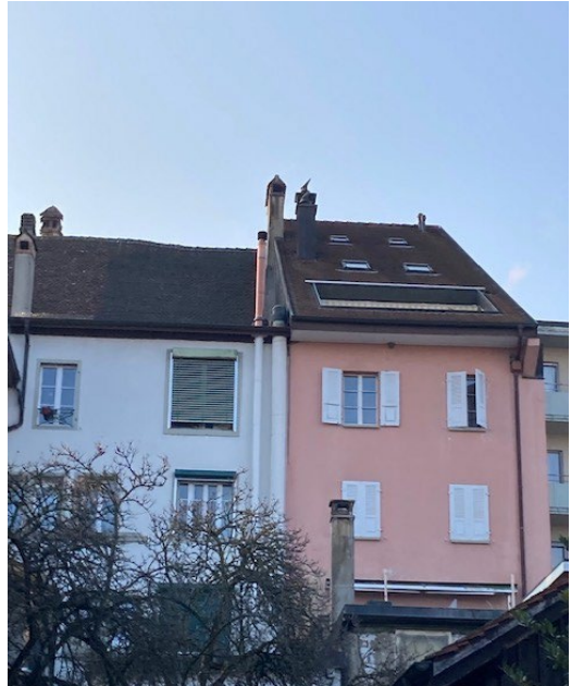
Conduit de fumée
