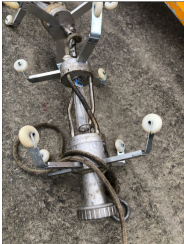
Figure 11 : Train de lampes UV pour mise en place et durcissement de la chemise synthétique
