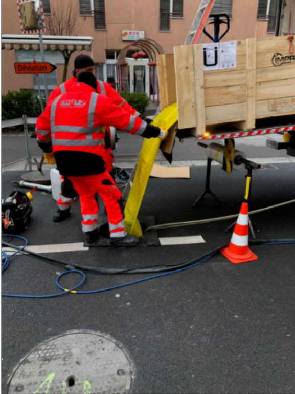
Figure 10: Insertion de la chemise synthétique dans le collecteur
