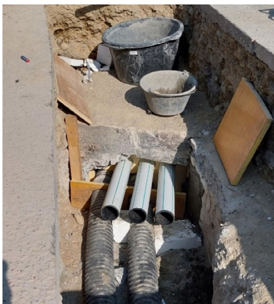
Remplacement de la conduite de chauffage de L'Ancienne Promenade, avril 2022
