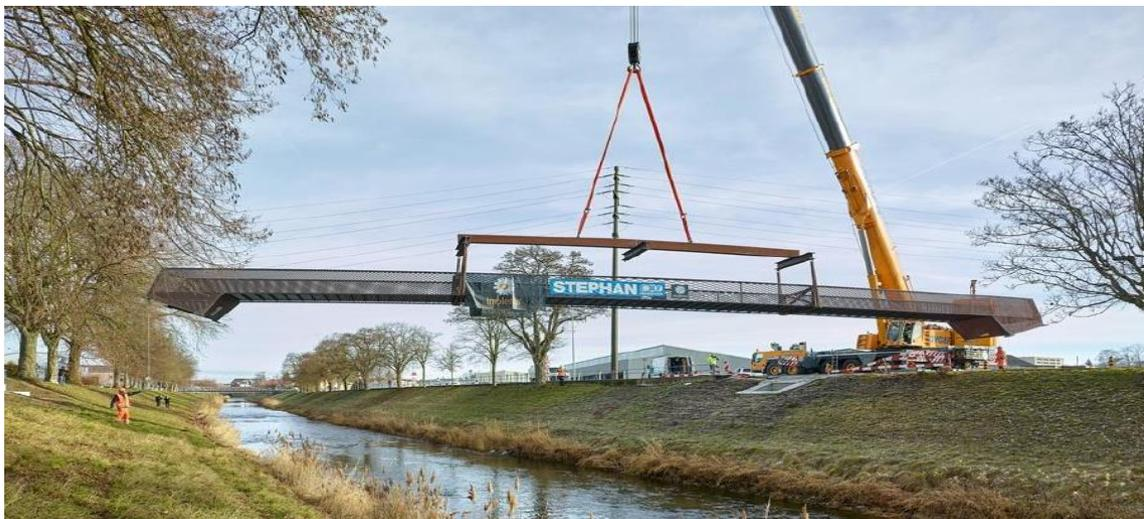
Illustration de manutention de la passerelle des Rives de la Broye avec grue de 500 tonnes
