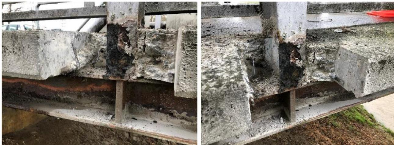
Corrosion aux interfaces acier, acier sous les zones en béton (à traiter)
