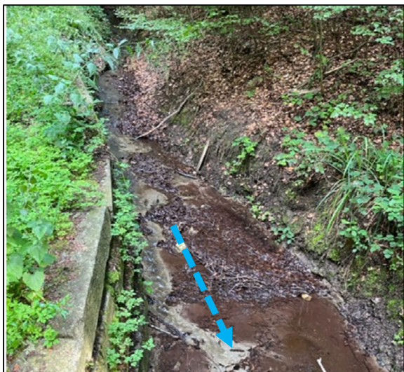
Figure 14 : Lit du Motélon en amont de l'ouvrage de décantation
