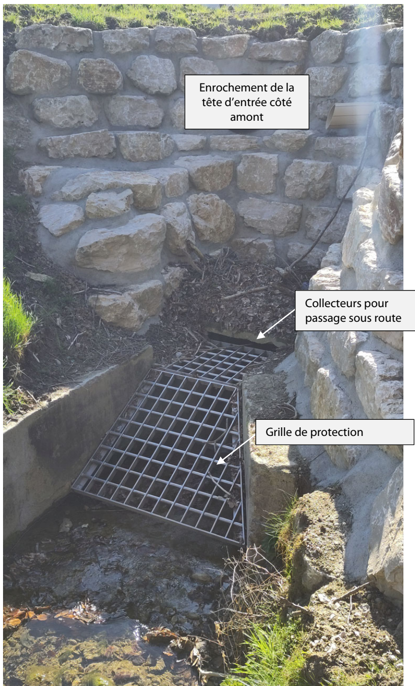
Figure 13 : Evaluation 2, exemple de tête d'entrée amont, avec grille de protection
