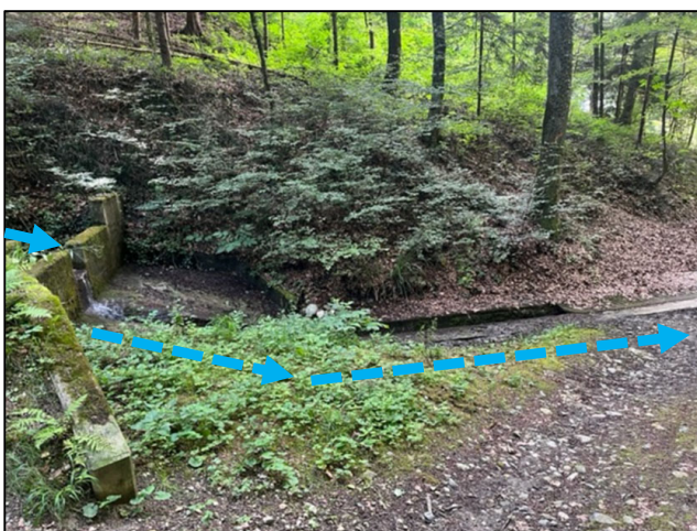
Figure 16 : Sortie de l'ouvrage de décantation
