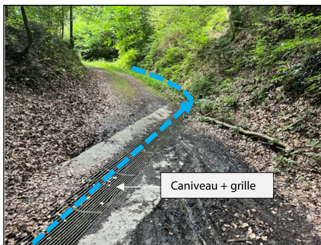
Figure 17 : Écoulement du Motélon en aval de l'ouvrage de décantation
