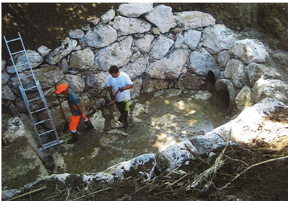
Figure 2 : Enrochement réalisé en 2018 côté amont du ruisseau
