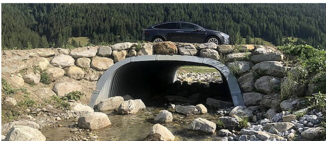
Figure 11 : Evaluation 1, exemple de demi-buse métallique
