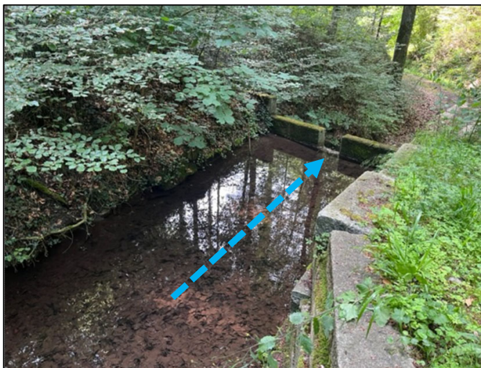
Figure 15 : Ouvrage de décantation
