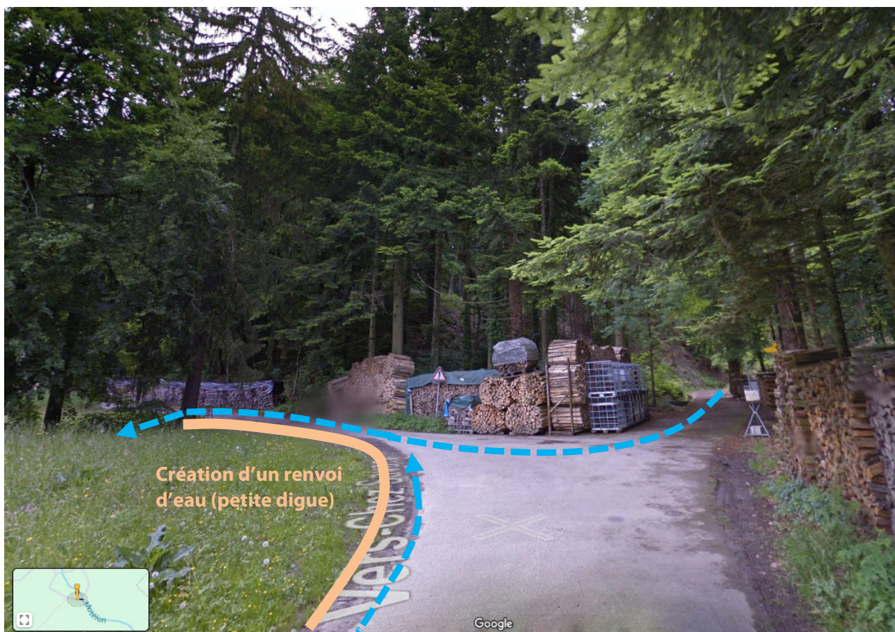
Figure 23 : Reprofilage du chemin et renvoi d'eau sur DP (mesure n° 3 page 14)
