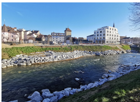
Des enrochements pour protéger les berges de l'érosion
