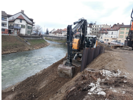
Travaux sur les berges - hiver 2023
