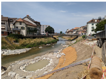
Travaux sur les berges - hiver 2023
