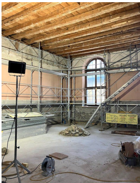
Travaux en cours extérieurs et état après démolition des revêtements et plafonds - nouvelle dalle
