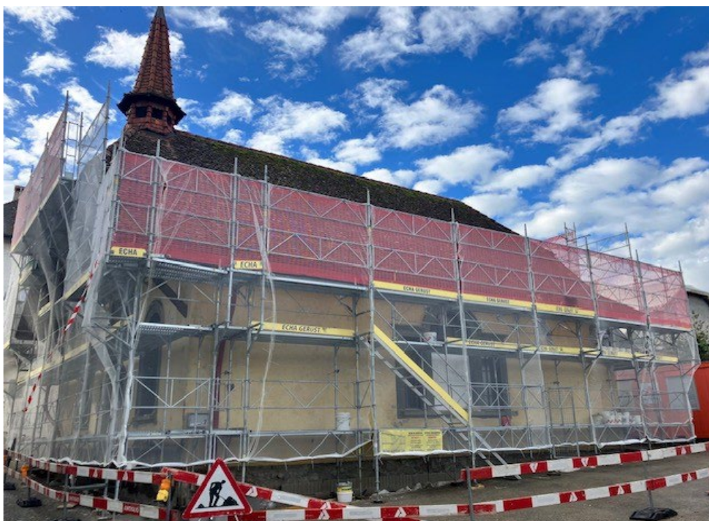
Echafaudages extérieurs - intervention sur les façades et toiture
