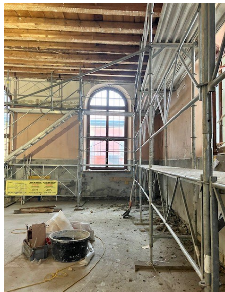
Travaux en cours extérieurs et état après démolition des revêtements et plafonds - nouvelle dalle
