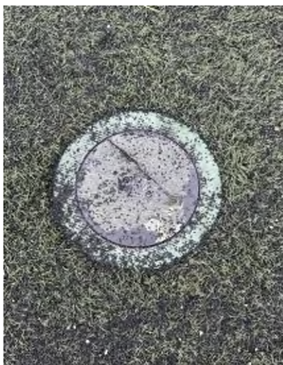
Buse d'arrosage - Terrain synthétique
