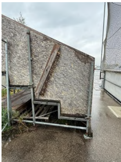
Etat détérioré des gradins
