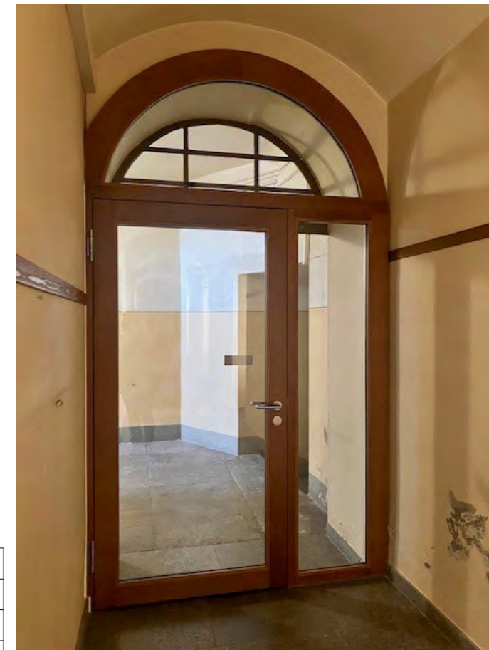
Mise en place d'une porte de compartimentage.
