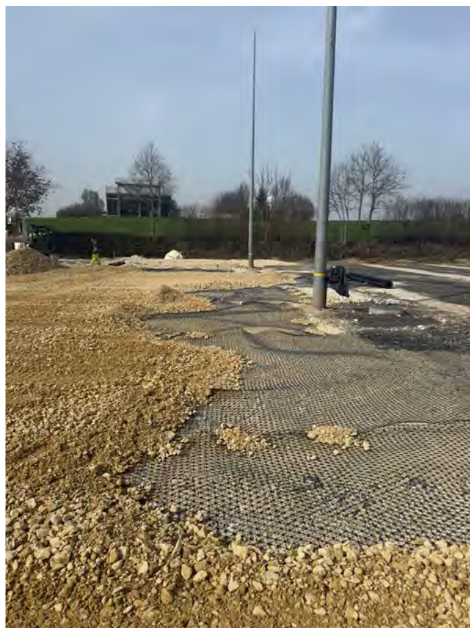
Pose de géogrid et mise en place de grave.
