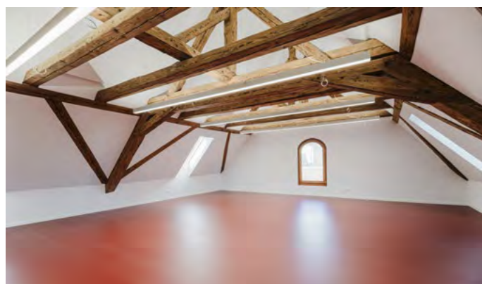
Salle de répétition de musique au rez-de-chaussez et salle à usage multiple à l'étage.
